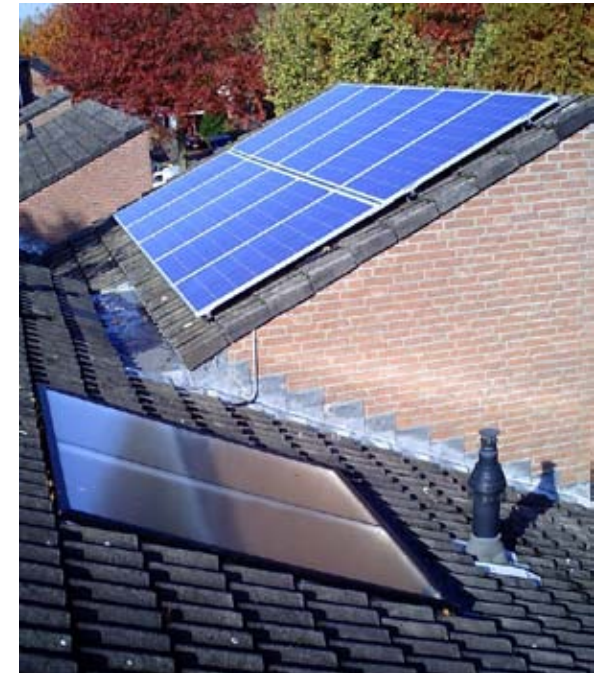
Zonnepanelen op het dak voor elektriciteit en een zonneboiler op de voorgrond voor warm water.
