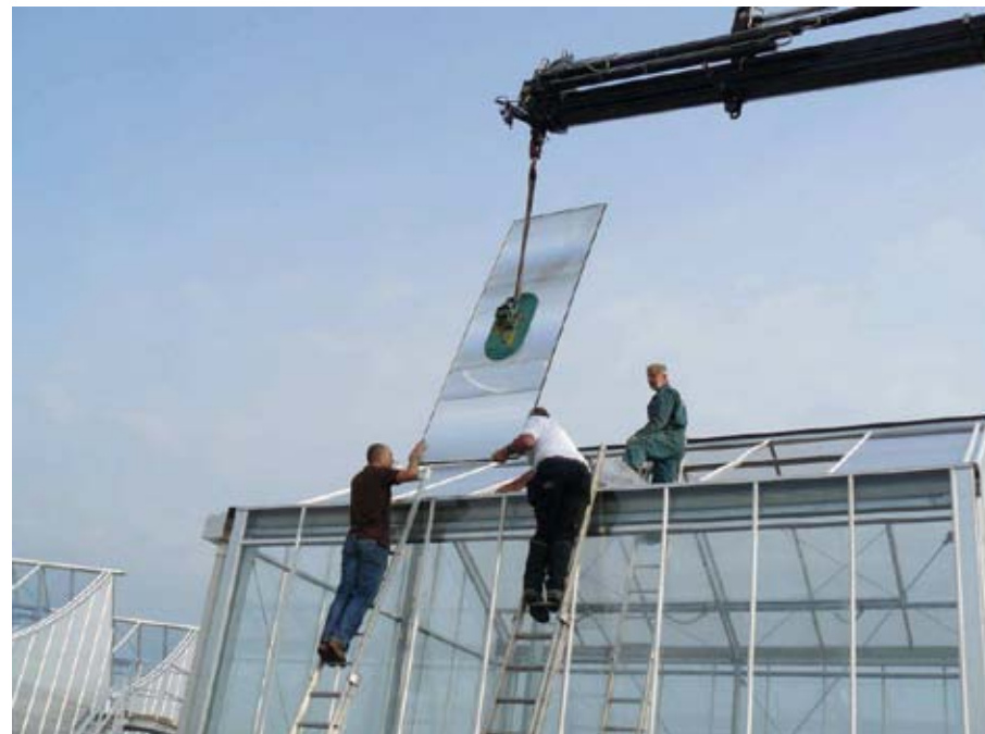
Een Fresnel-lens op glas wordt geïnstalleerd (bron: Technokas / Wageningen Universiteit)
